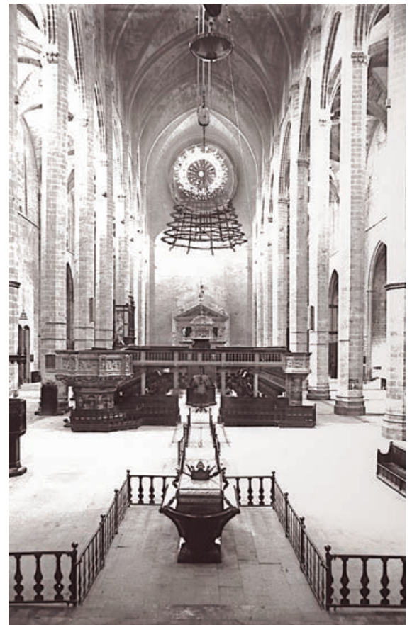
El cor abans de la reforma, col·locat enmig de la nau
