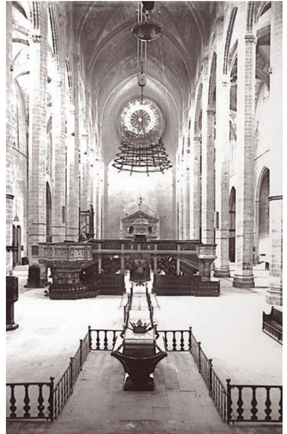
El coro antes de la reforma, colocado en medio de la nave
